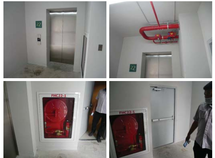
ภาพลิฟต์ดับเพลิง มีพื้นที่ไม่น้อยกว่า 6 ตารางเมตร สามารถจอดได้ทุกชั้น เป็นพื้นที่ปลอดควันและเปลวไฟ ไม่มีสิ่งกีดขวาง และเป็นที่ตั้งของตู้หัวจิตดับเพลิงประจำชั้นของอาคาร
