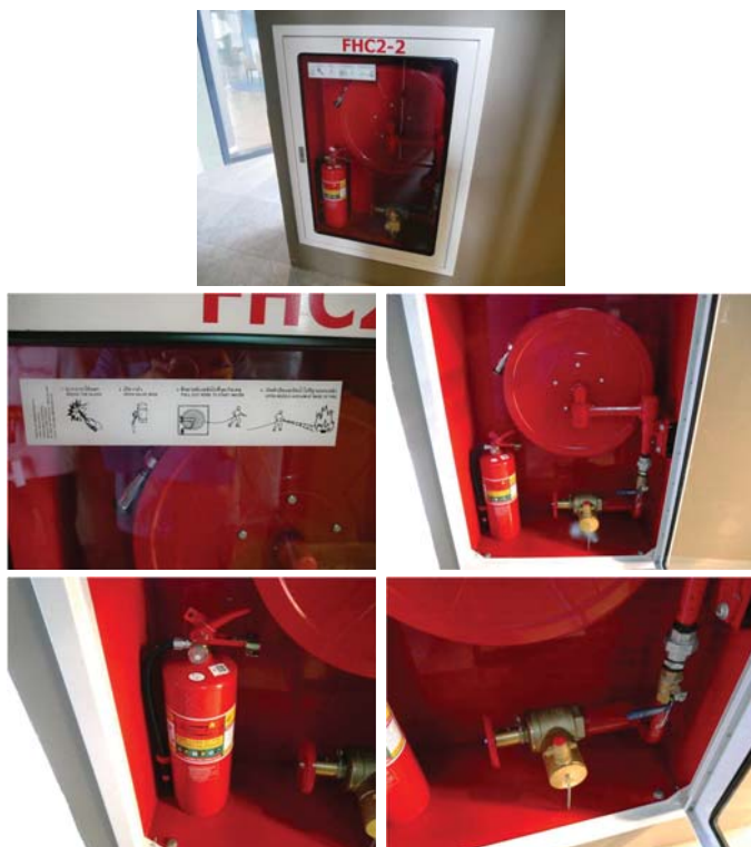
ภาพตู้ FHC สายฉีดน้ำดับเพลิง และถังดับเพลิง มีการตรวจสอบเบื้องต้นจากทางฝ่ายอาคาร
