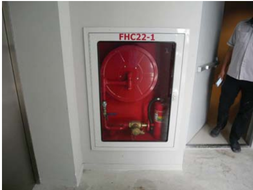
ตรวจสอบและติดตั้งป้ายแสดงวิธีการใช้งานสายฉีดน้ำดับเพลิงให้ครบทุกจุด
