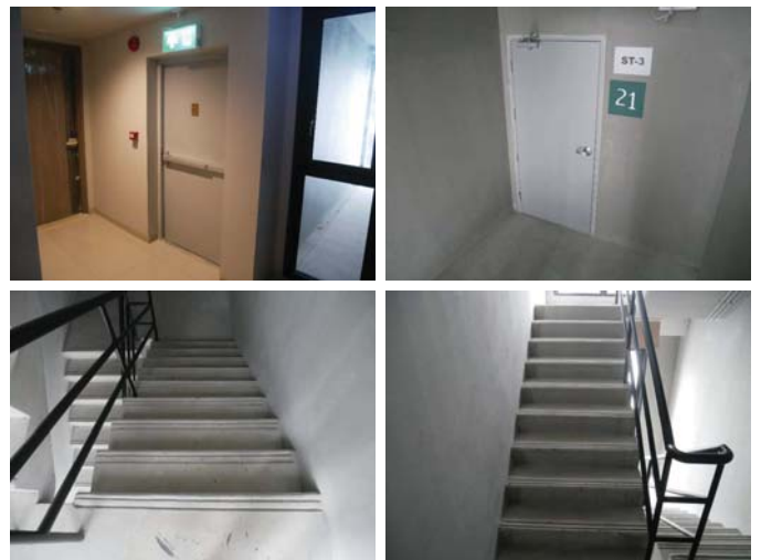
ภาพบันไดหนีไฟและเส้นทางหนีไฟ มีระบบแสงสว่าง ไม่มีสิ่งกีดขวาง ผนังหรือประตูทำด้วยวัสดุทนไฟ สามารถใช้หนีภัยในกรณีฉุกเฉินได้
