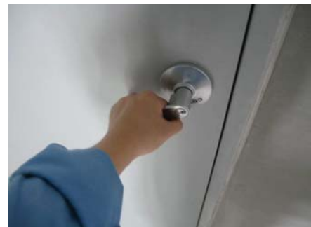
ตรวจสอบ วางแผนการอพยพ และการเข้าช่วยเหลือให้ชัดเจน เนื่องจากประตูหนีไฟไม่สามารถเปิดกลับเข้าตัวอาคารได้
